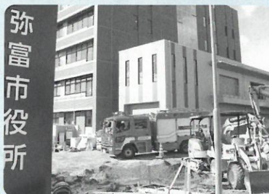
●工事現場に消防車が止まっている様子
